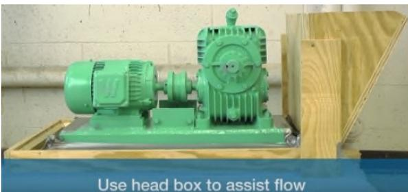
Asegúrese de que el encofrado es seguro y estanco para evitar movimientos y fugas durante la colocación y el curado del grout. La zona debe estar libre de vibraciones excesivas. Parar la maquinaria adyacente hasta que el grout se haya fraguado. En climas cálidos, las placas base y los cimientos deben estar a la sombra de la luz solar directa. Los sacos y cubos de grout deben almacenarse a la sombra antes de su uso. En tiempo frío, la temperatura de las placas base y los cimientos
