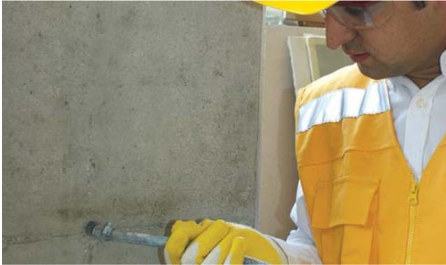
3. Limpie la perforación con aire a presión para eliminar los residuos. Repetir esta operación tres veces.
