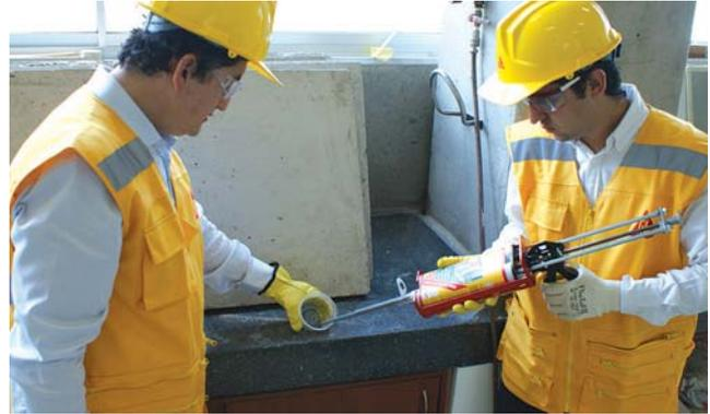
4. Presione el gatillo varias veces (no en la perforación) hasta que por la punta de la boquilla salga el adhesivo con un color y consistencia uniforme. No utilice este material.
