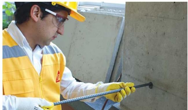
6. Limpie la barra a anclar e introdúzcala girándola lentamente hasta que ésta toque el fondo de la perforación de tal forma que el adhesivo se desplace a la superficie.
