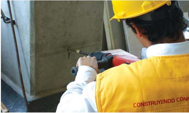
1. Realice la perforación con un taladro rotopercutor y la broca adecuada (que deje rugosa la superficie de la perforación).
