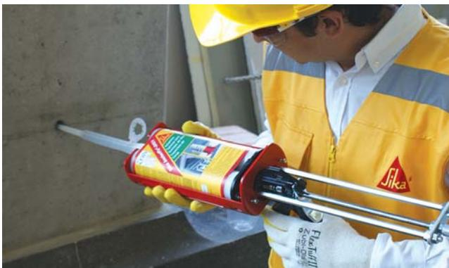
5. Introduzca la boquilla hasta el fondo de la perforación e inyecte el adhesivo hasta llenar 3/4 de la misma. Retire suavemente la boquilla a medida que se llena la perforación. En perforaciones profundas usar una extensión.
