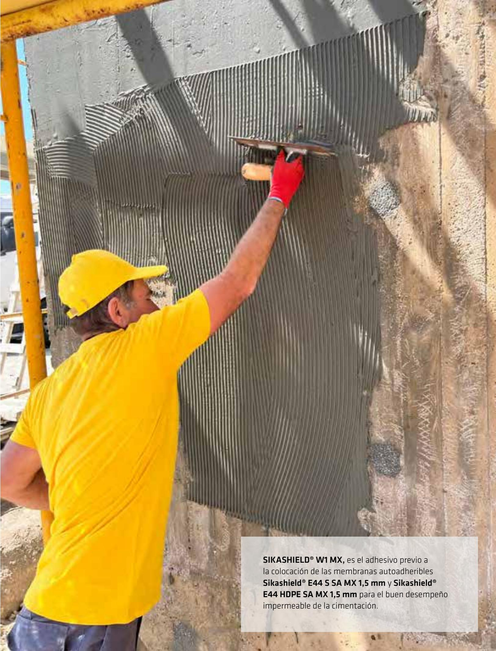
**SIKASHIELD® W1 MX**, es el adhesivo previo a la colocación de las membranas autoadheribles **Sikashield® E44 S SA MX 1,5 mm** y **Sikashield® E44 HDPE SA MX 1,5 mm** para el buen desempeño impermeable de la cimentación.
