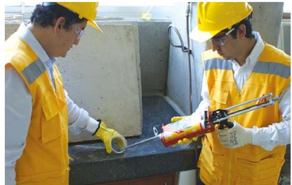
4. Presione el gatillo varias veces (no en la perforación) hasta que por la punta de la boquilla salga el adhesivo con un color y consistencia uniforme. No utilice el material si no cumple con esta condición..
