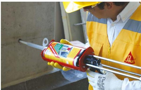
5. Introduzca la boquilla hasta el fondo de la perforación e inyecte el adhesivo hasta llenar 3/4 de la misma. Retire suavemente la boquilla a medida que se llena la perforación. En perforaciones profundas usar una extensión.
