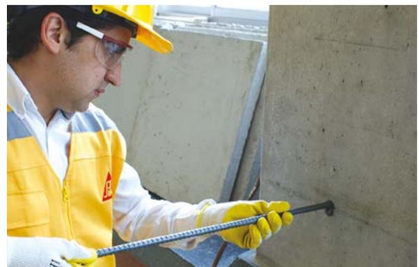
6. Limpie la barra a anclar e introdúzcala girándola lentamente hasta que ésta toque el fondo de la perforación de tal forma que el adhesivo se desplace a la superficie.
