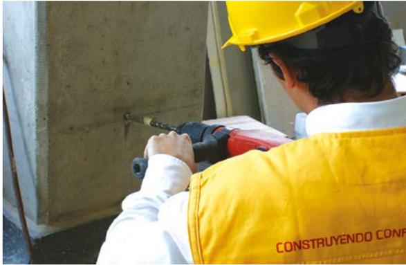
1. Realice la perforación con un taladro rotopercutor y la broca adecuada (que deje rugosa la superficie de la perforación).
