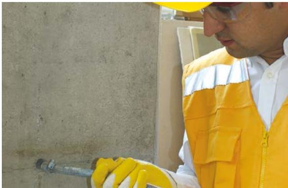
3. Limpie la perforación con aire a presión para eliminar los residuos. Repetir esta operación tres veces.
