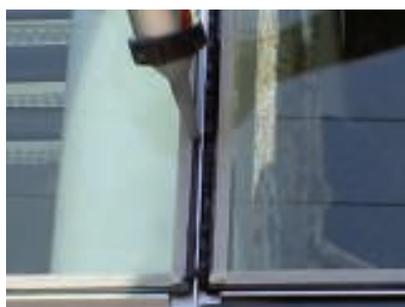
*Sikasil WS 305 CN para sellado de juntas entre módulos de cristal.*
