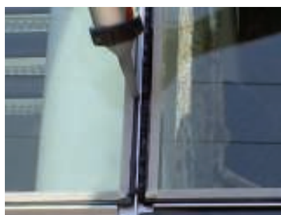
Sikasil WS 305 CN para sellado de juntas entre módulos de cristal.
