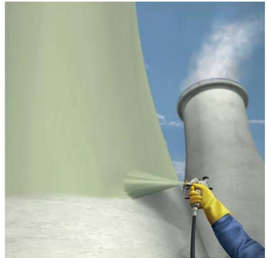
**PROTECION Y RECUBRIMIENTO / RECUBRIMIENTOS ANTI-CARBONATACION.**
