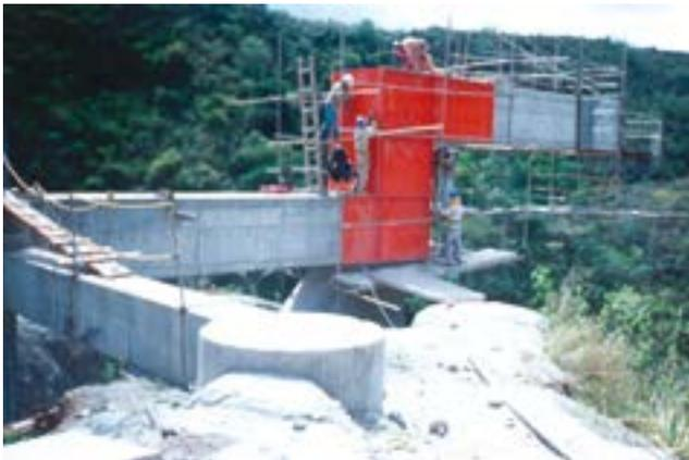
Láminas metálicas en nudo de en una viga cajón en concreto con relleno epóxico inyectado.
