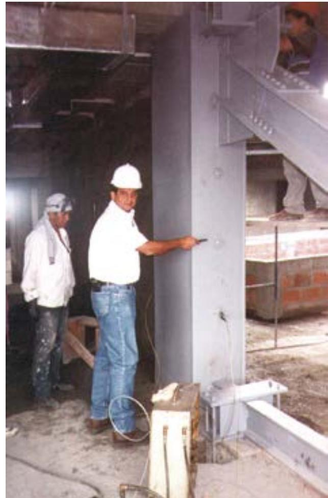
Encamisado de columnas metálicas con relleno epóxico inyectado.
