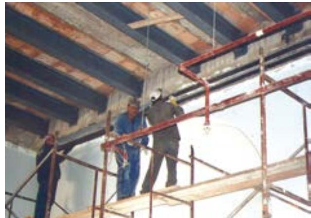
Adición de perfiles metálicos en losa y pega de láminas CFRP en vigas de edificio comercial.
