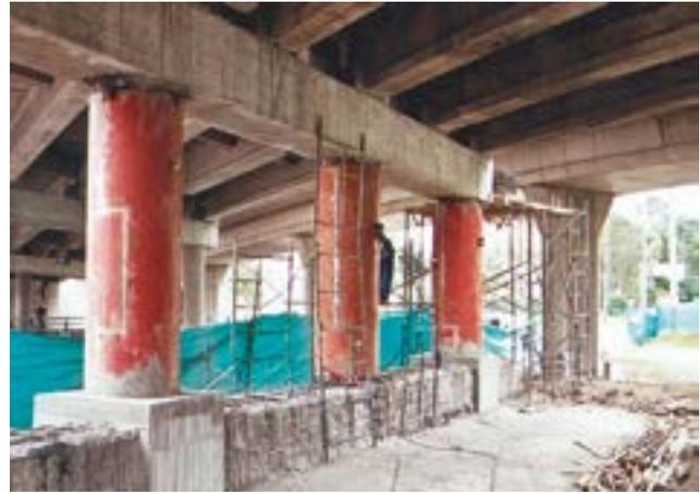
Encamisado de vigas con concreto y láminas metálicas en columnas y relleno con mortero sin retracción en puente.
