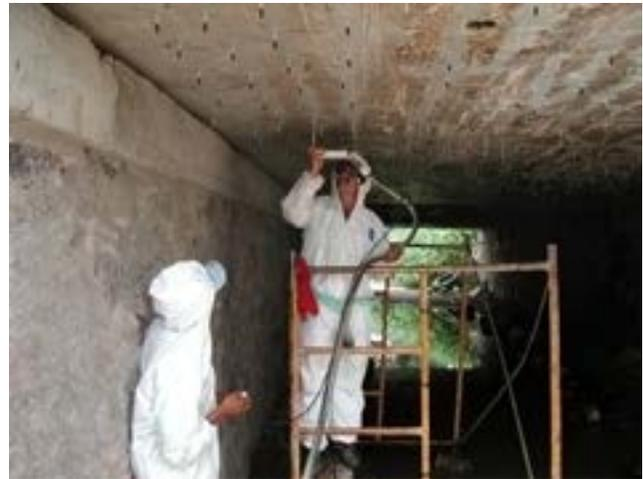
Inyección de grietas con resina epóxica de baja viscosidad.
