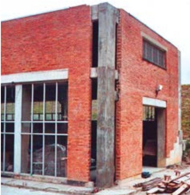
Encamisado de columna con concreto de baja retracción en edificio industrial.
