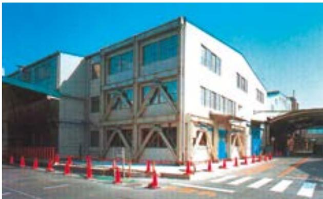
Adición de arriostamiento dúctil con panel de cortante, riostras y marco metálico (Japón).
