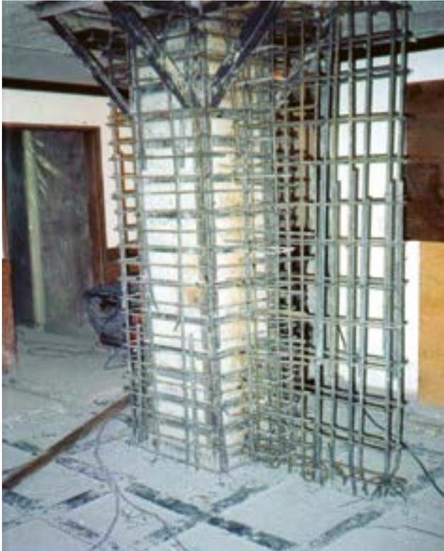
Encamisado de columna con concreto de baja retracción en edificio industrial.
