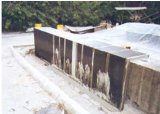
Encamisado en concreto de baja retracción y láminas CFRP en viga (T) invertida.
