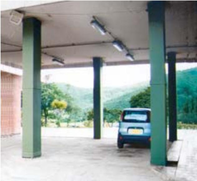
Encamisado de columnas con láminas metálicas y relleno con concreto sin retracción.
