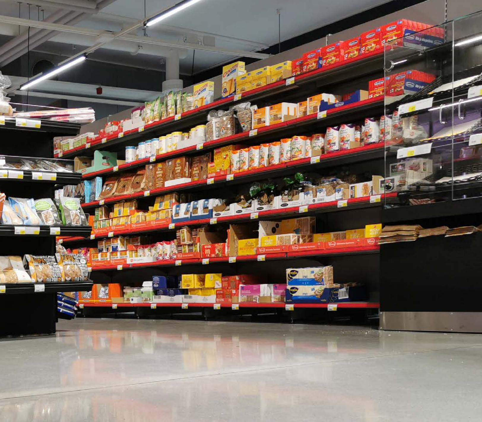
**Sikafloor® Dry Shake Terrazzo** está fabricado con áridos minerales de forma única, cemento Portland modificado especial, y al reaccionar con Sikafloor®-931 Finishing Aid, proporciona una extraordinaria adherencia y dureza superficial.
