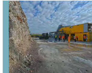
06. Estabilización de taludes
