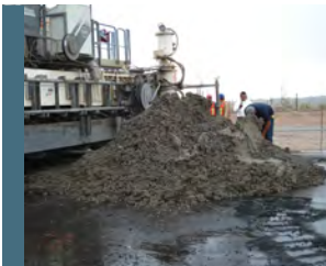
07. Colocación del concreto hidráulico
