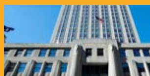
REPARACIÓN Y PROTECCIÓN
