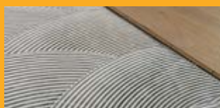
INSTALACIÓN DE PISOS
