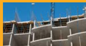
FUNDICIÓN IN-SITU Y PREFABRICADOS DE CONCRETO
