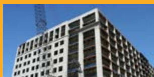
REPARACIÓN DE CONCRETO
